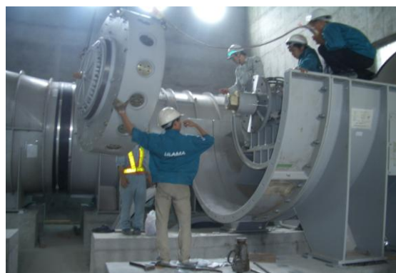
Lắp đặt nhà máy thủy điện
